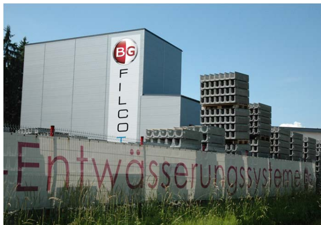
Die neue FILCOTEN®-Produktionshalle am Standort Oberwang. ©BG-Graspointner
